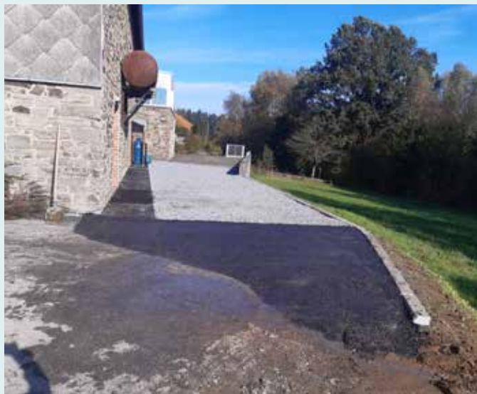
Aménagement de la cour de la salle d'Opont : pose de bordures en pierre bleue et en béton. Pose de tarmac à chaud pour le trottoir et mise en place de grenaille pour la cour.
